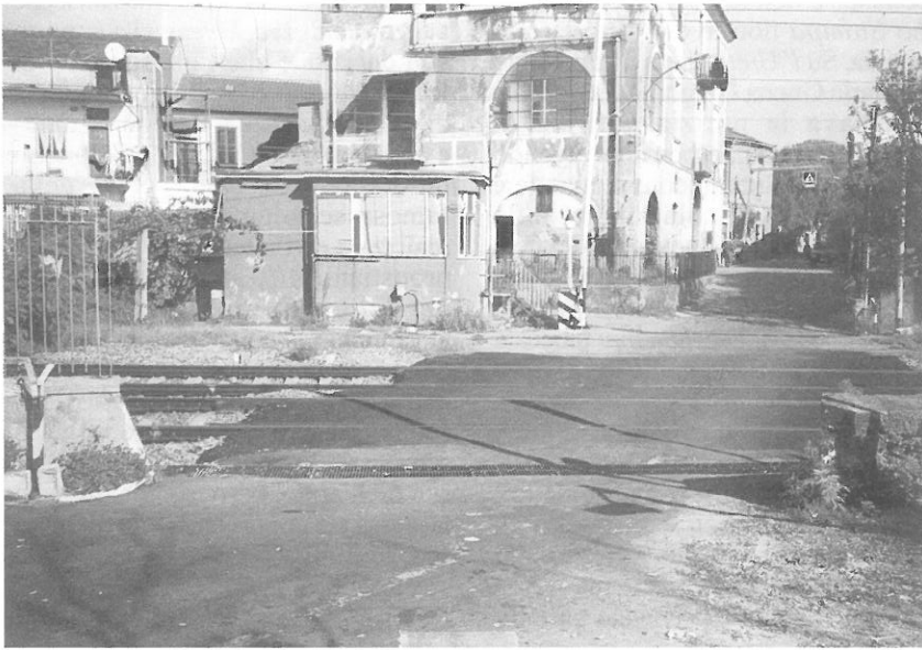
Il casello-blocco 60 a Scavata Case Rosse
