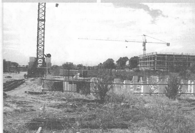
(Foto 4) - Fondamenta del fabbricato della Cooperativa "Polizia di Stato - La Speranza" (vista da nord). A destra il fabbricato della CO.GE.MA.
