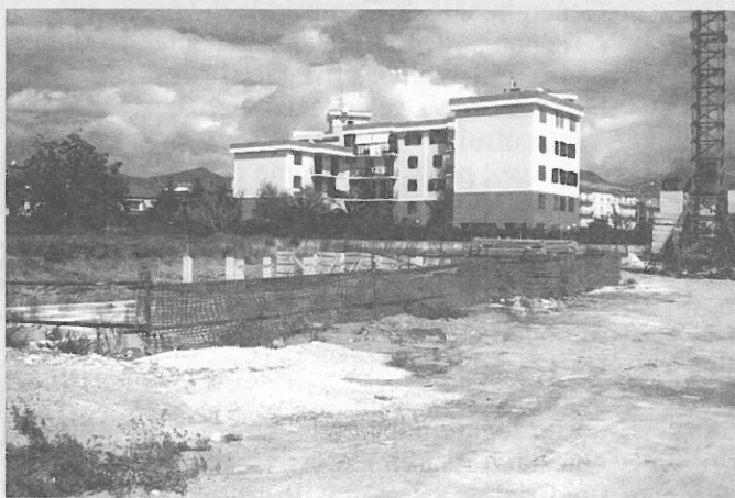
(Foto 5) - Fondamenta del fabbricato della Cooperativa "Polizia di Stato - La Speranza" (vista da sud).
