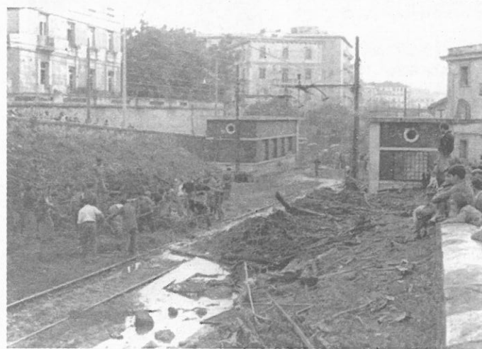
Salerno, 26/10/1954. Si scava al passaggio a livello di Porta Rotese.
