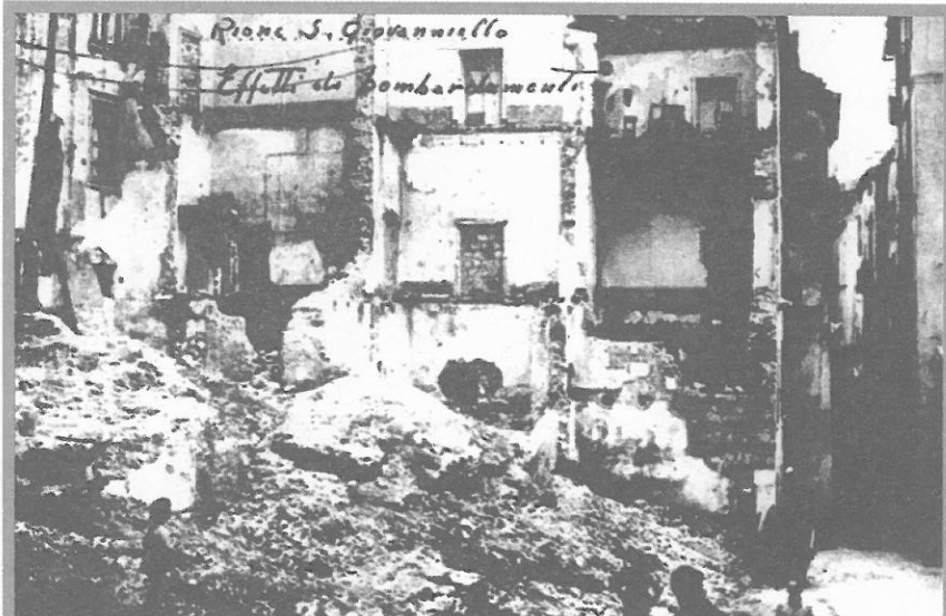
21 giugno 1943. Rione S. Giovanniello località tra Piazzetta S. Petrillo / Via Canapari. Durante il bombardamento notturno 44 persone rimasero sepolte ma non si poterono raggiungere per il franare delle macerie. (Archivio Comune di Salerno).
