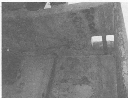
Scolo di gronda dal loggiato.
