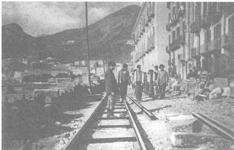
Salerno 1909. Posa dei doppi binari in città nei pressi del Palazzo della Provincia.
