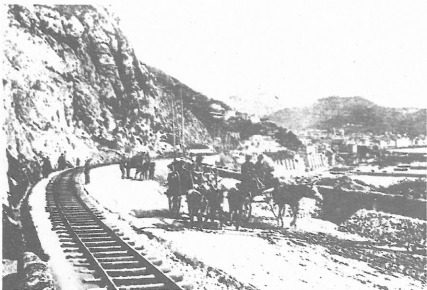
Salerno Gennaio 1909. Posa dei binari verso Pompei all'altezza dell'attuale Baia Hotel.
