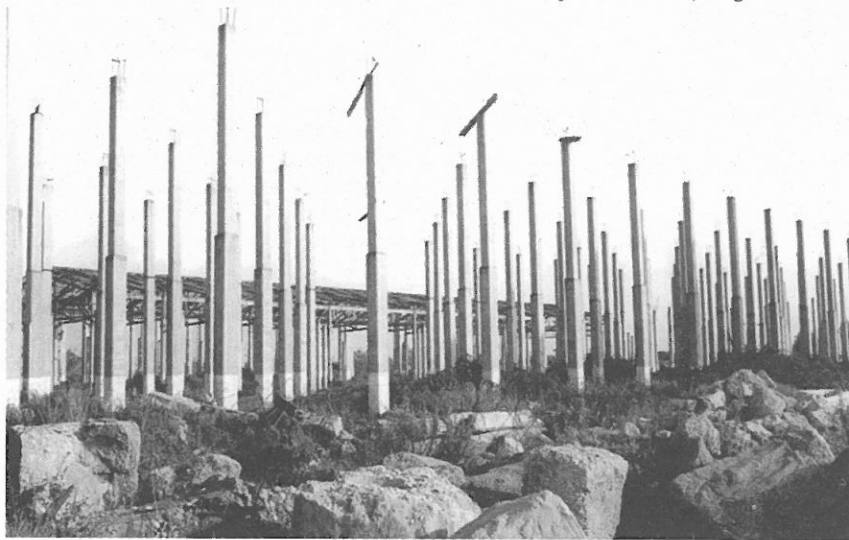
I pilastri residui che reggevano i capannoni dell'ex tabacchificio "Farinia".
