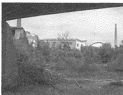
Sotto un pilone del ponte.
