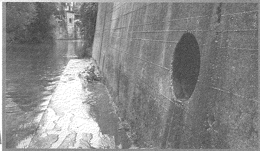
Scarico industriale, a circa 100 metri dal ponte, verso mare
