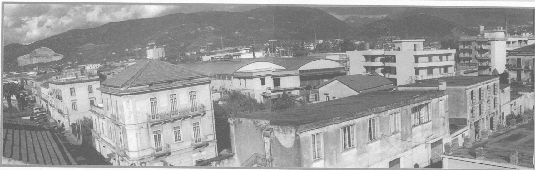
Incrocio via Roma - via Budetti. L'ex fabbrica Cirio e i capannoni della ex Debar.
